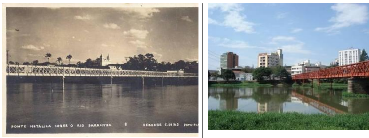
FIG. 57 - Ponte Metálica Nilo Peçanha. Acervo Prefeitura Municipal de Resende e Ponte Metálica em 2012. Foto: Andréa Auad, 2007.
