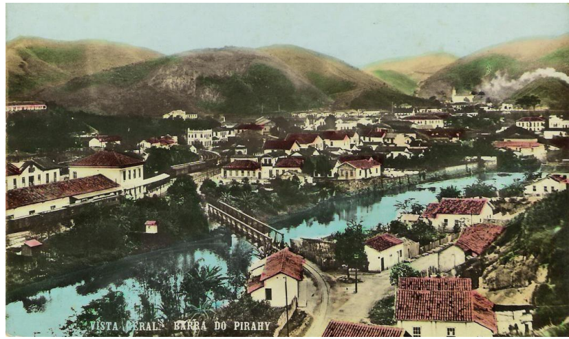
FIG. 220 - Acervo: Centro Cultural de Barra do Pirai, Postal 15 - Ponte Arlindo Rodrigues
