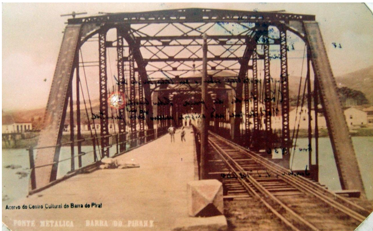
FIG. 208 - Ponte Metálica 1898, Acervo: Centro Cultural de Barra do Piraí.
