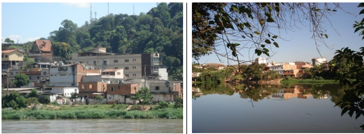
FIG. 73 - Ocupação da área marginal do Rio Paraíba do Sul – Barra Mansa e Volta Redonda, respectivamente. Foto: Andréa Auad, PIC PARAÍBA DO SUL 2007.
