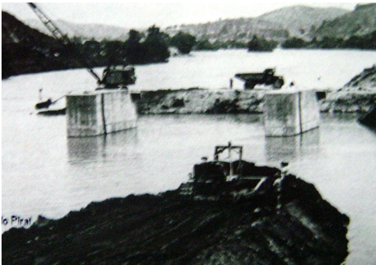
FIG. 213 - A barragem sendo implantada sobre o rio Paraíba do Sul. 1950. Acervo: centro Cultural de Barra do Pirai. Doação: Delmo Arvellos Pinto.
