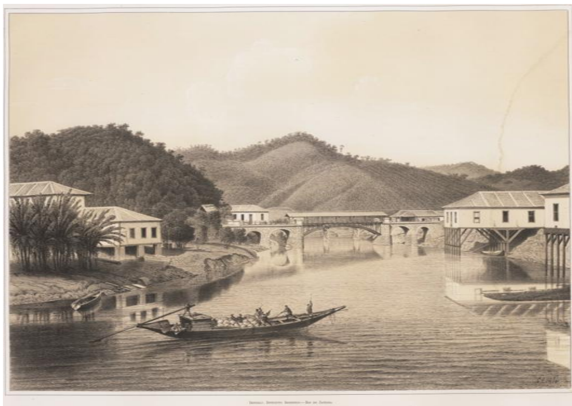
FIG. 39 - Linde, Carlos, m. 1873. Brasil : Estrada de Ferro de D. Pedro II. Ponte sobre o rio Pirahy (perto da estação Barra do Pirahy) [Gravura 12]. Acervo Biblioteca Nacional.
