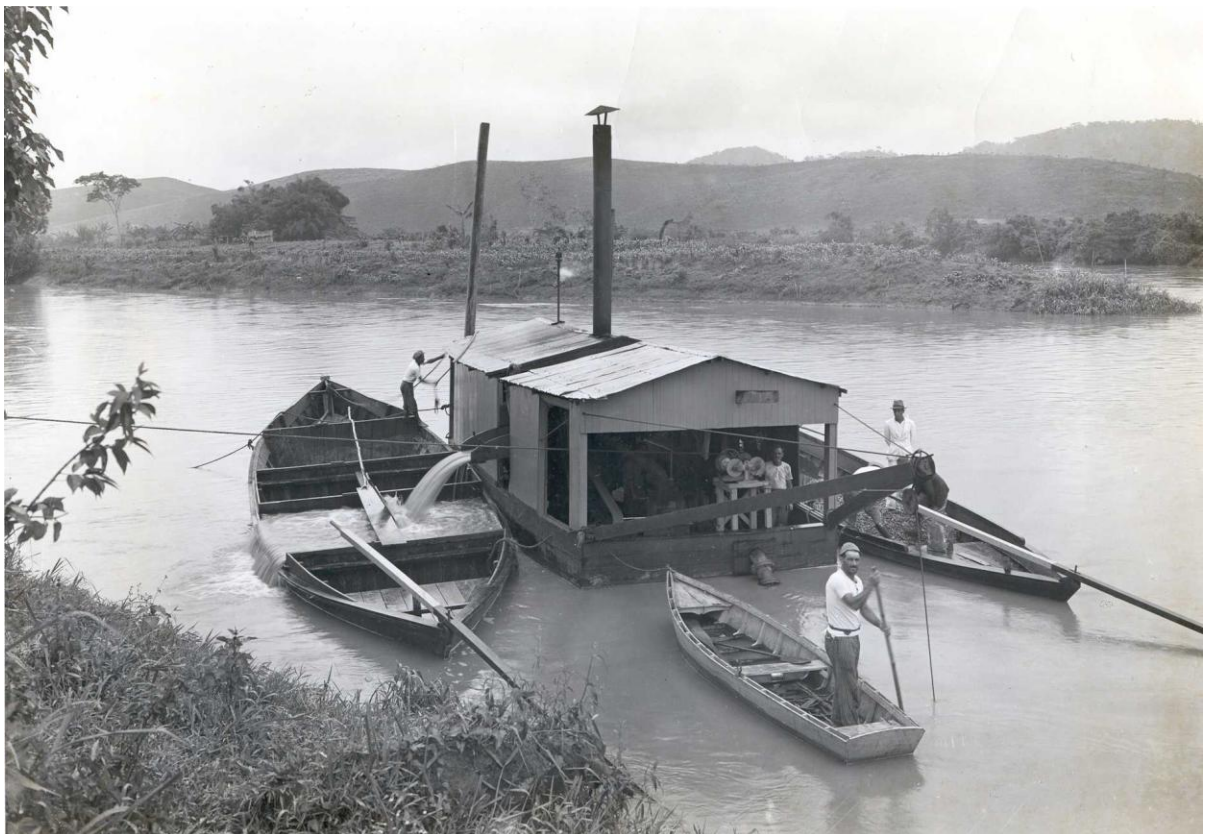
FIG. 153 - Estruturas de retirada de areia em Volta Redonda. Arquivo CSN, s/d.
