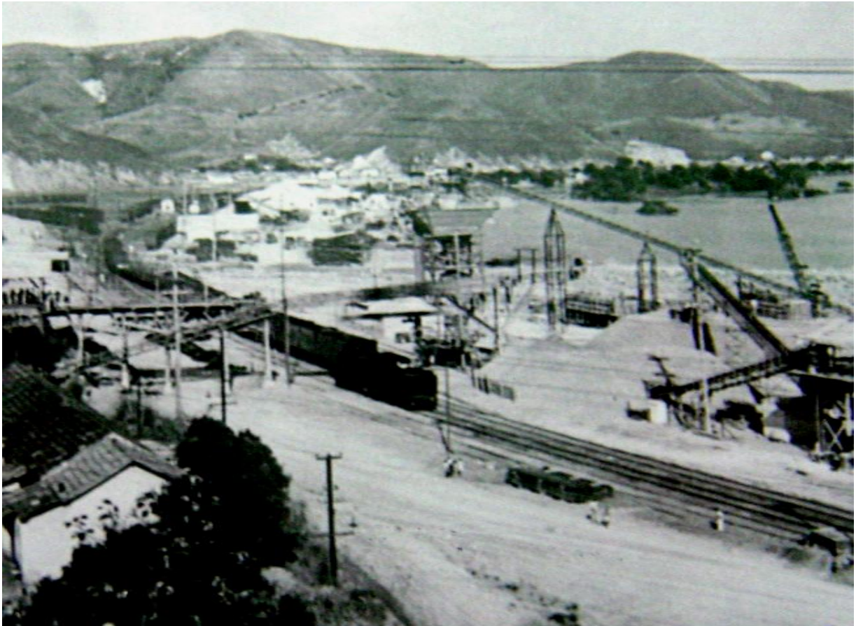
FIG. 212 - Construção da Barragem de Santa Cecília, 1950. Acervo: centro Cultural de Barra do Piraí. Doação: Delmo Arvellos Pinto.
