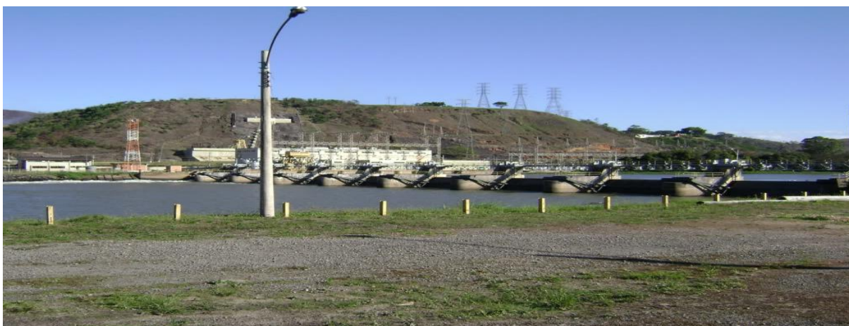
FIG. 68 - Usina elevatória de Santa Cecília em Barra do Piraí. Disponível em: www.lightenergia.com.br , acesso em 13 de agosto de 2013.
