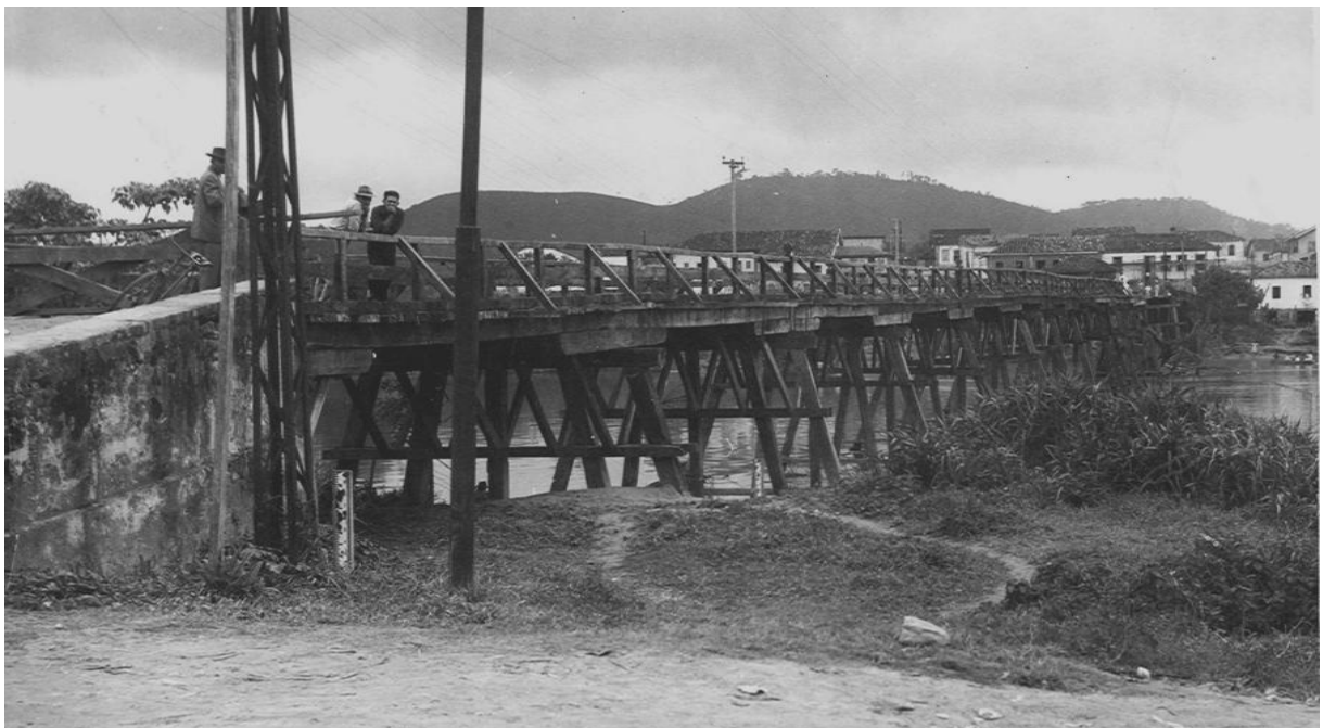
FIG. 151 - Ponte de Madeira e a intensificação das relações distritais. Arquivo CSN, s/d.
