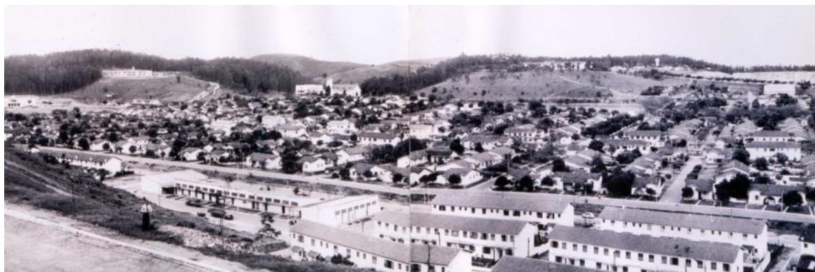
FIG. 162 - Ocupação da Vila Operária, projetada por Atílio Corrêa Lima. Acervo PMVR, s/d.
