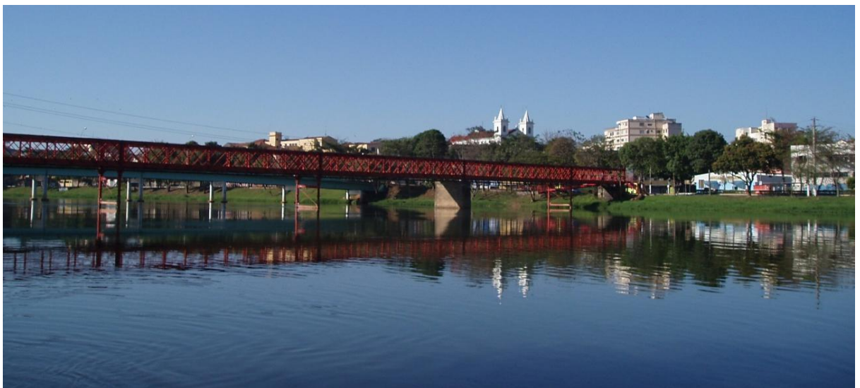
FIG. 95 - Unidade paisagística composta pela Ponte Metálica e o Rio Paraíba do Sul em Resende. Foto: Andréa Taucei, 2008.
