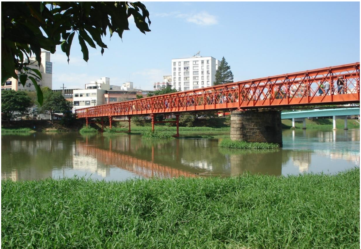
FIG. 07 - A Ponte Metálica em Resende. Foto Andréa Auad 2007
