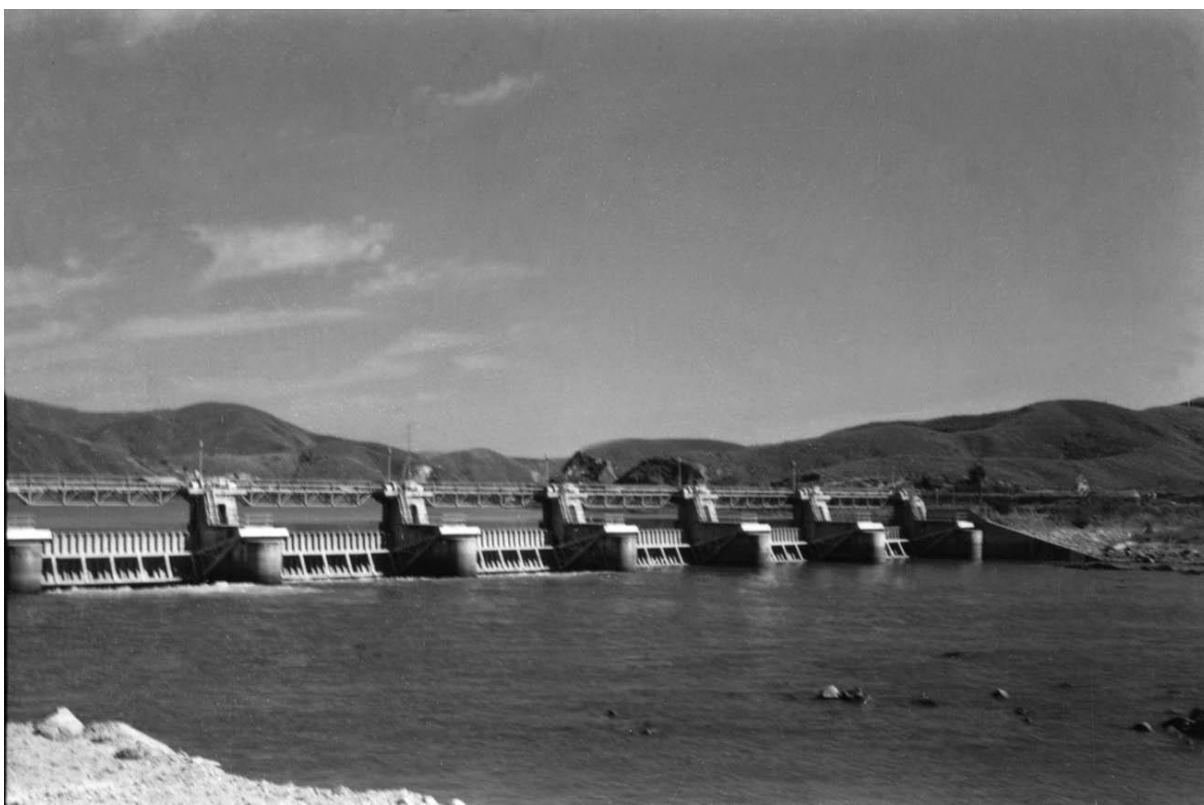
FIG. 214 - Barragem de Santa Cecília Barra do Pirai, década de 1950.
