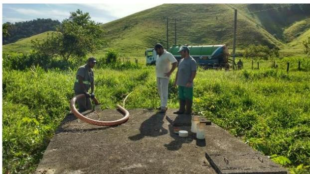
Figura 9 e 10: Fossa e filtro anaeróbico e procedimento de limpeza.
